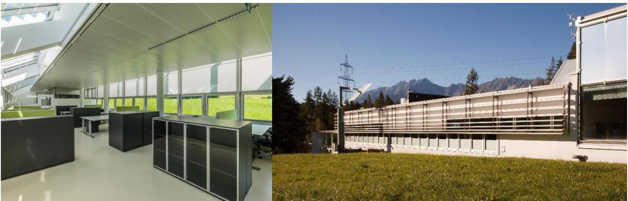
Abb. 3: Innen- und Außenansicht des Bartenbach F&E-Gebäudes; im linken Bild sind die Oberlichter erkenntlich, das rechte Bild veranschaulicht die außenliegenden statischen Tageslichtlamellen
