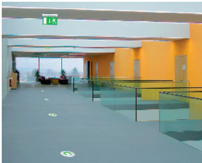
Bild 5: Mit einem bodennahen elektrischen Sicherheitsleitsystem, wie etwa hier dem Floor-RZ Bodenstrahler, kann eine optimale Erkennbarkeit der Fluchtwegrichtung realisiert werden
